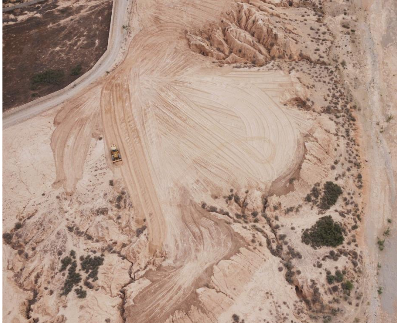
Planierungsarbeiten mit Baumaschine am Ufer des Oued Oaar
